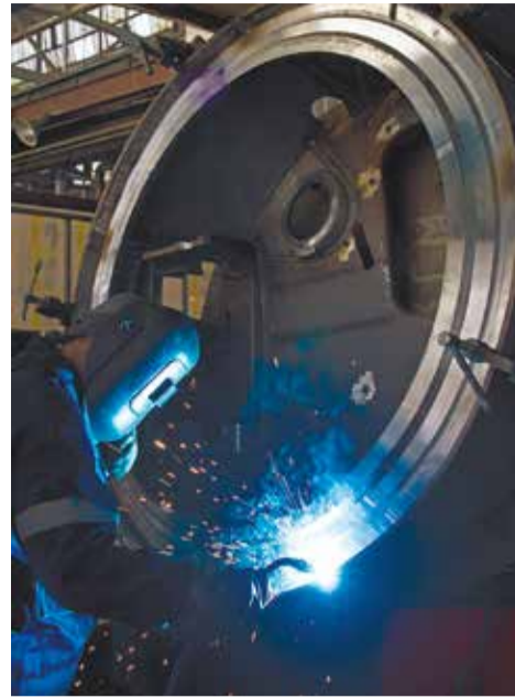
Сварка башни БМД
